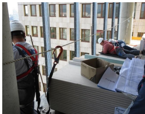
Slika 4: Pravilna uporaba osebne varovalne opreme
